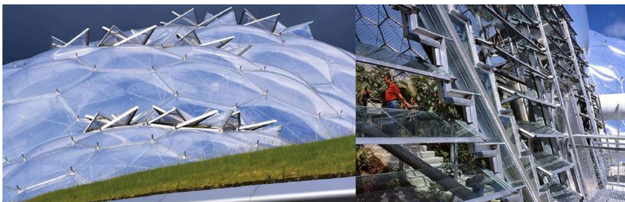
FIGURA 08 » Escotillas y paneles abatibles de ventilación en el Eden Project , Graham Gaunt – Arup Group.
