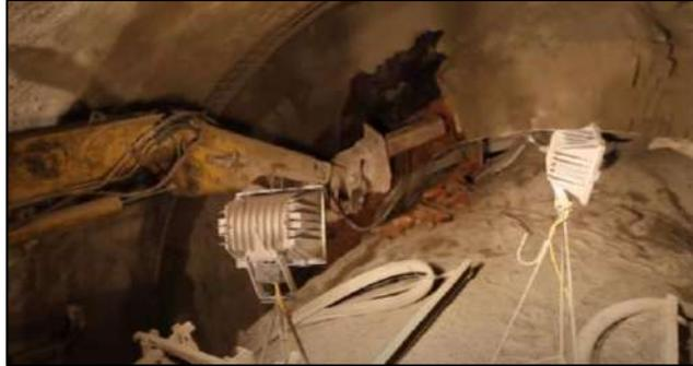
**Ilustración 263: Demolición y excavación de la sección ampliada (Fuente: GTA, 2014)**
