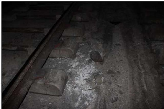
**Ilustración 180: Detalle de los fragmentos desprendido sobre la plataforma. P.K. 227+070 (Fuente: Amberg e Infraes, 2020)**
