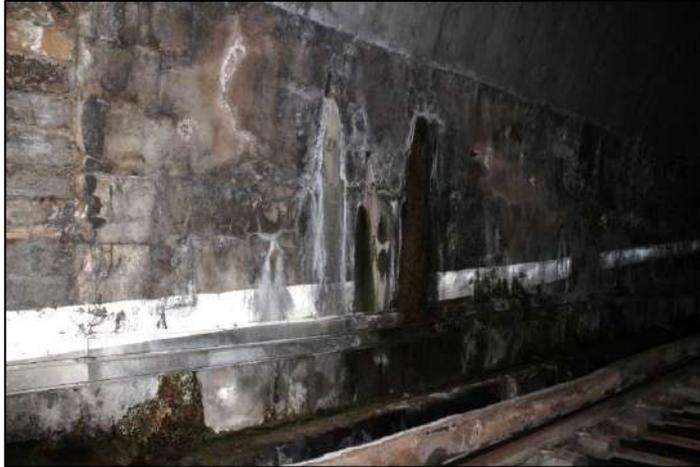
**Ilustración 177: Restos de humedades y áreas mojadas de filtraciones en el hastial izquierdo P.K. 226+899 (Fuente: Amberg e Infraes, 2020)**
