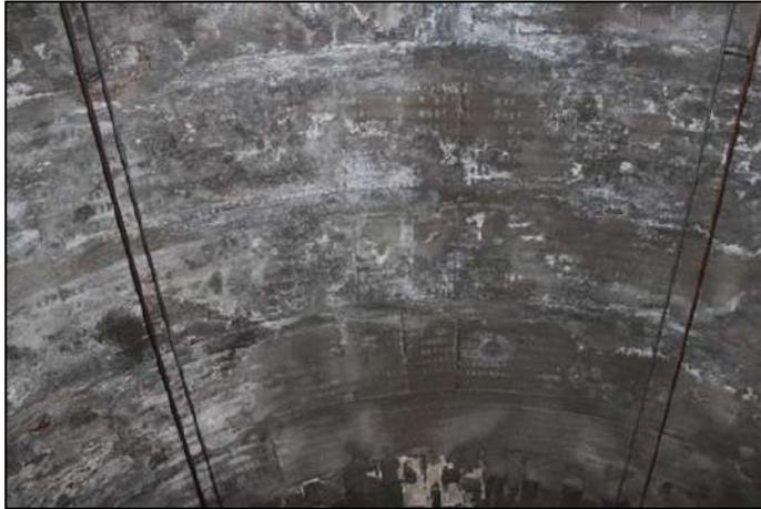
**Ilustración 185: Detalle de la falta de recubrimiento P.K. 226+980 (Fuente: Amberg e Infraes, 2020)**
