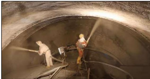
**Ilustración 264: Gunitado de bóveda y hastiales (Fuente: GTA, 2014)**
