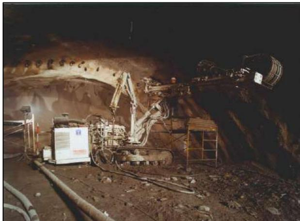
**Ilustración 220: Paraguas de micropilotes en la obra de emergencia (Fuente: Geocisa, 2001)**
