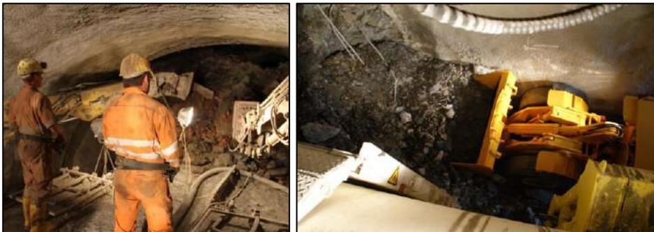
**Ilustración 250: Excavación superior y retirada de material por el lateral (Fuente: GTA, 2017).**
