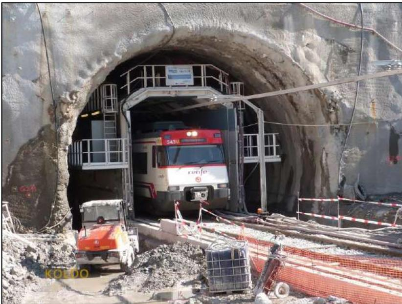
**Ilustración 261: Sección ampliada en emboquille por máquina TES. Circulación del servicio de cercanías por la vía centrada (Fuente: Bidasotarra blogspot, 2017)**
