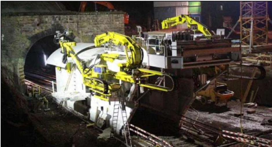
**Ilustración 247: Máquina ubicada en emboquille, con vía única (Fuente: GTA, 2017)**
