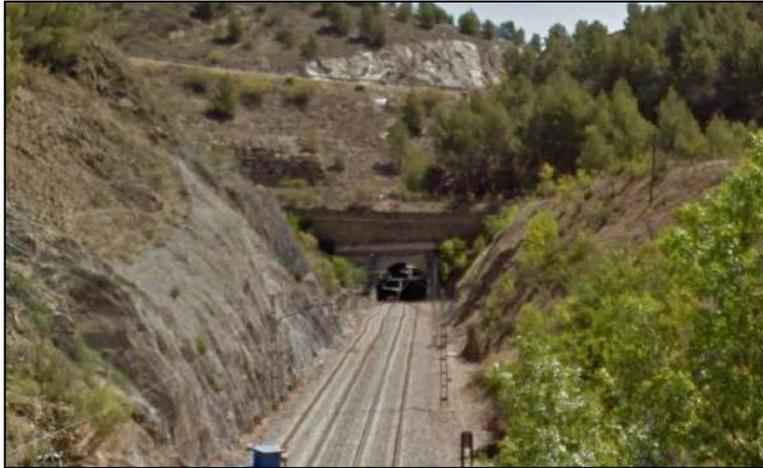
**Ilustración 193: Emboquille de entrada y trinchera (Fuente: Google Earth, 2020)**
