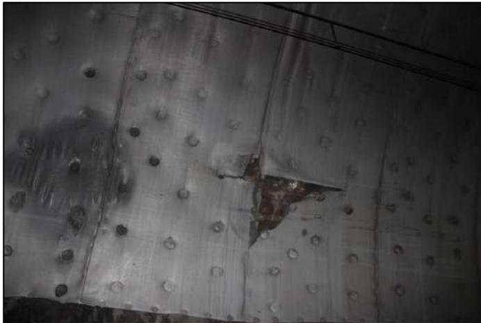
**Ilustración 190: Detalle de la lámina desgarrada por rozaduras en el hombro izquierdo (Fuente: Amberg e Infraes, 2020)**
