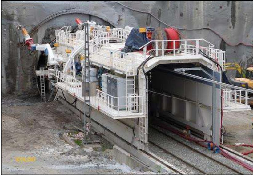
**Ilustración 260: Máquina TES colocada en emboquille para el inicio de la ampliación (Fuente: Periódico construcción, 2018)**
