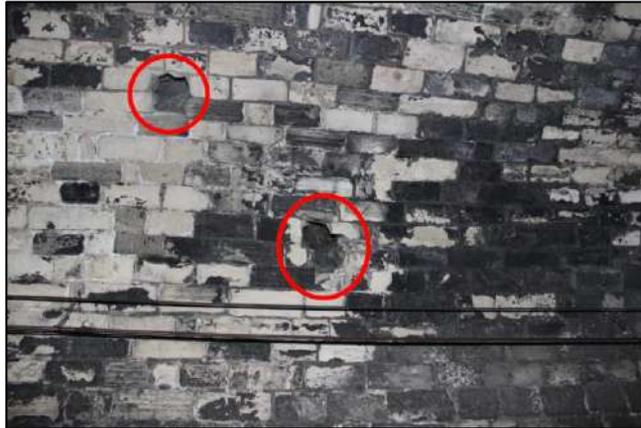
**Ilustración 179: Detalles de las oquedades producidas por el desprendimiento de varias piezas P.K. 227+078 (Fuente: Amberg e Infraes, 2020)**
