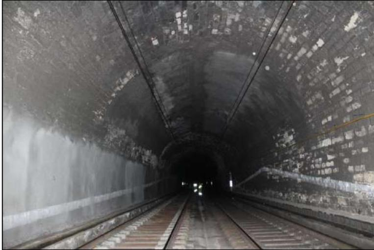
**Ilustración 181: Zonas de hormigón proyectado en bóveda y hastiales (Fuente: Amberg e Infraes, 2020)**
