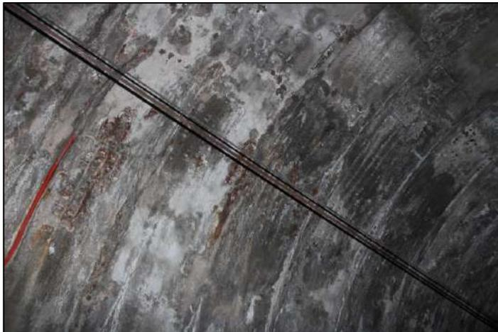
**Ilustración 184: Detalle de área de armadura oxidada al descubierto P.K. 226+975 (Fuente: Amberg e Infraes, 2020)**
