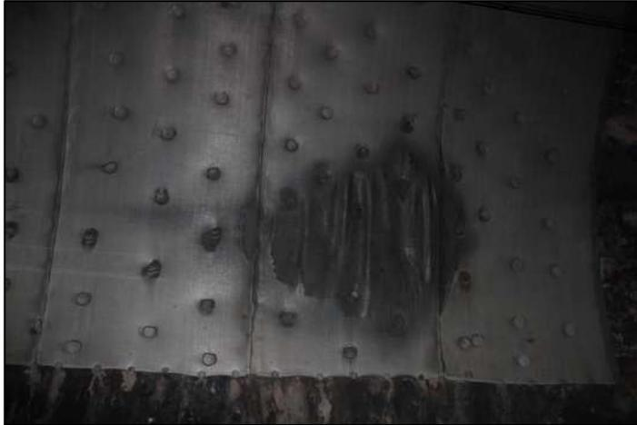
**Ilustración 189: Detalle del tramo de lámina fundida en el hombro izquierdo (Fuente: Amberg e Infraes, 2020)**
