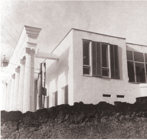
Fig. 8. Vista d'epoca del fianco, con l'attacco del pórtico ottocentesco al nuovo edificio.
