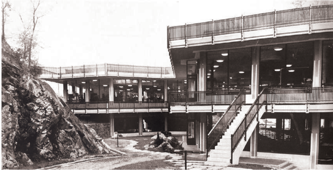
Fig. 15. Vista del edificio con el acceso directo al comedor.
