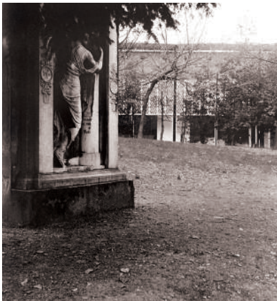
Fig. 10. La fachada sur de la galería mientras desaparece gradualmente detrás de la exuberante vegetación del parque.
