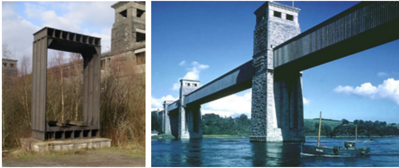
Figs. 6 y 7. Fotografía de la sección transversal del Puente Britannia. Robert Stephenson 1850
