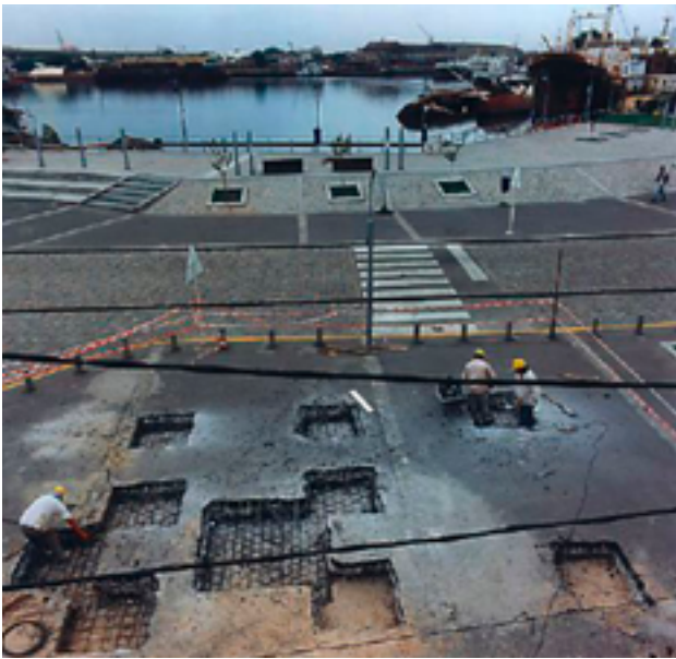
Figura 7. HEJDUK, John /Buenos Aires Construcción replanteo de La Máscara Refugio. Fotografía: Daniel Casoy
