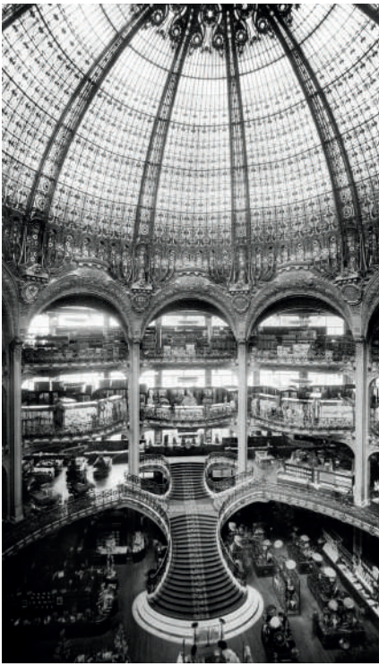
Figura 15: Hall principal de las Galeries Lafayette, con la escalera de hormigón armado aún en su lugar y la gran vidriera de Jacques Gruber en la cúpula (Archivos Históricos de Galeries Lafayette).
