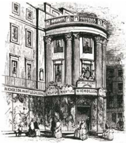
8- Argyle Warehouse, 246-248 Regent St., Londres, 1953. Lunas de vidrio a todo lo largo de la planta baja que hacen aún más pesada la composición superior. Fuente: Abdurgham.
