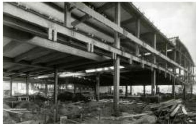
Figuras 18 a 20. Pabellón de España de la Feria Mundial de Nueva York, 1964. Estructura y montaje de prefabricados durante su construcción en 1963. Fuente: Fondo Javier Carvajal García-Valdecasas.
