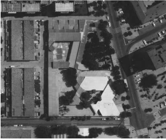
Fig. 10. Vuelo fotográfico con las áreas de residencia de la Capilla demolidas, agosto 1988. [CECAF serie 4 a CCF R-1188 N-6678. 1/3.000]
