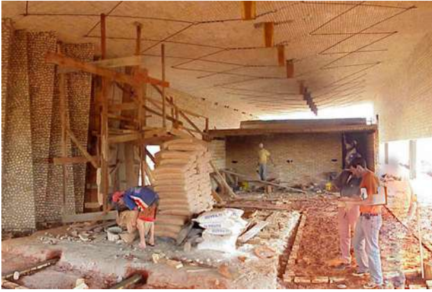
Fig. 05. Artesanos en plena faena construyendo parte del muro en la "Estancia Las Anitas", fotografía: Gabinete de Arquitectura.
