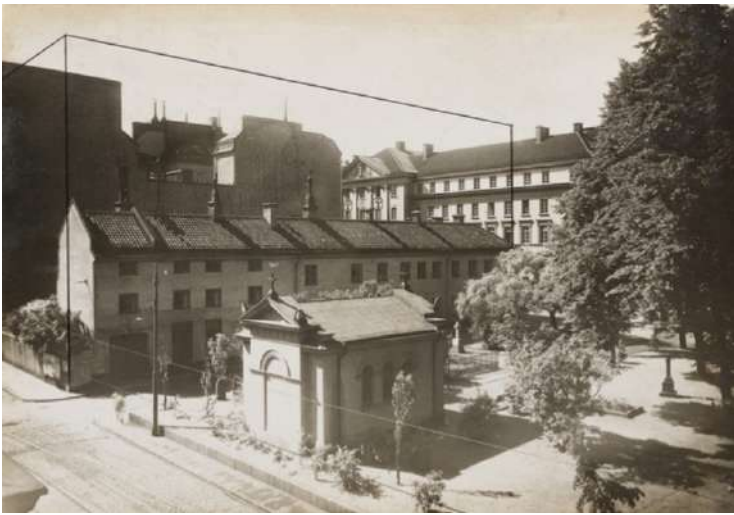
Fig. 01. Instituto Nacional de la Seguridad Social. Fotografía área del solar. Lewerentz, 1928. ARKM.1973-05-03089.
