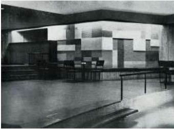
Fig. 07. J.A. Corrales. Bolera americana. Vistas interiores. R.N.A. nº167-nov. 1955
