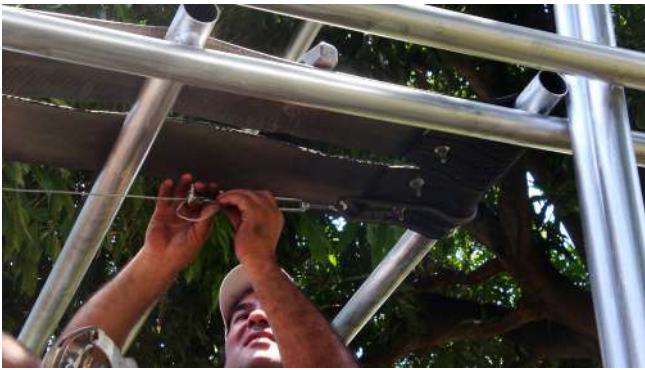
Fig. 02. Artesano trabajando en la realización de pruebas a escala 1:1 de la estructura y tejido que componen la “Plaza de nuestros sueños”, fotografía: Lukas Fúster.
