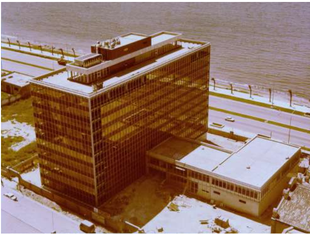
Fig. 22. José Ferragut Pou. Imagen aérea del Edificio GESA, Palma, 1963-1975. Archivo José Ferragut Pou.
