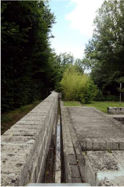
Fig. 12. Georges Descombes, Parque en Sauvy, Lancy, Ginebra, 1980-1986 . Vista del Puente túnel.
