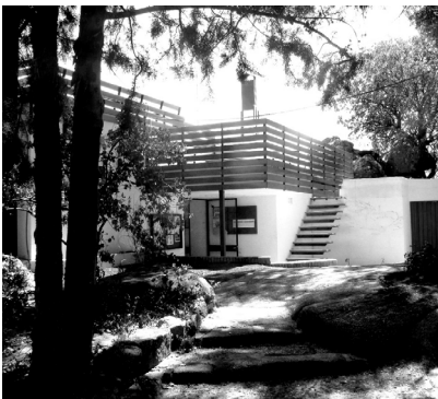
Fig. 24. Club náutico. Estado actual. Encuentro de la estructura con el terreno. Autoría personal.
