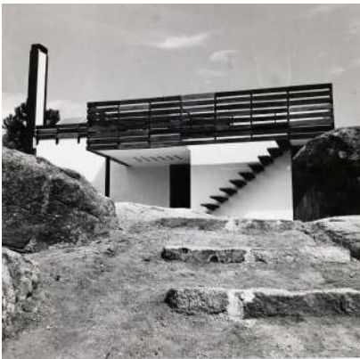
Figs. 27 y 28. Club náutico. Estado actual. Encuentro con el terreno y acceso. Autoría personal
