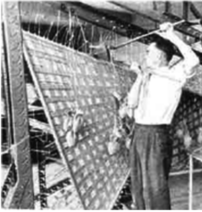
Fig. 08. Maquetas de madera contrachapada postesada con alambres, para ensayar la construcción por paneles delgados de hormigón prefabricado. Las caras libres se cargaban con saquitos de arena para tensionarlas. En: RC Resúmenes de Construcción 3. Poema Electrónico . María José Pizarro & Oscar Rueda. 1999. Pág. 4.
