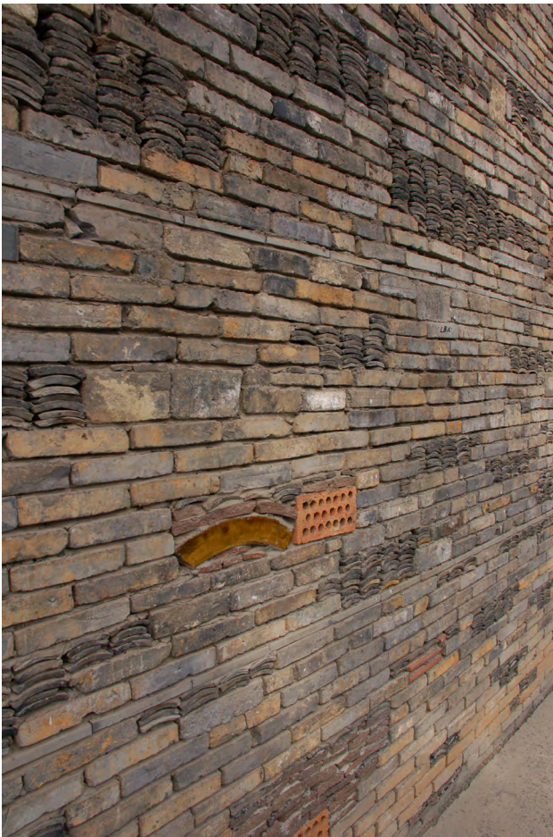
Fig. 14. Vista cercana de un muro wapan
