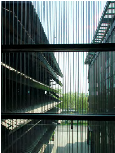
Fig. 09. Centro Internacional de Internet en Wuzhen
