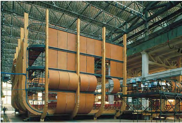
Fig. 20. El arca en el interior del Padiglione Ansaldo (Milán) en 1985, cuando es trasladada desde Venecia y donde permanecerá desmontada hasta ser transportada, pieza a pieza, a los almacenes de la Scala milanesa. La gruesa piel perimetral de madera que envuelve el espacio escenográfico central permite dar cabida a la orquesta y a los artilugios acústicos necesarios [fotografía] Archivio Luigi Nono, Fondazione ONLUS [consulta 5 de mayo 2018] Disponible en: http://www.luiginono.it/it/album/fotoalbum-luigi-nono?page=6
