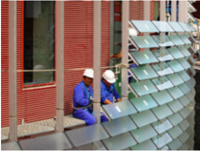
15- Jean Nouvel. Torre Agbar, Barcelona, 2003. (Detalle)
