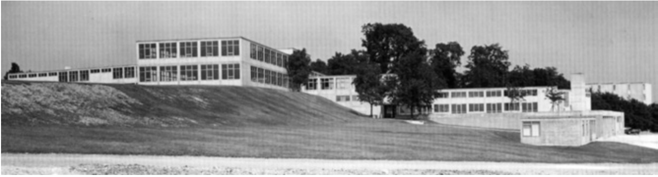
16- Max Bill. HFG Ulm, vista desde el suroeste con la caída de los edificios en la colina.
