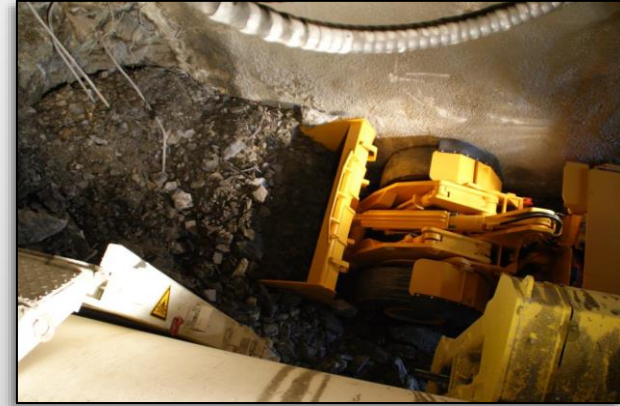
Retirada de material
