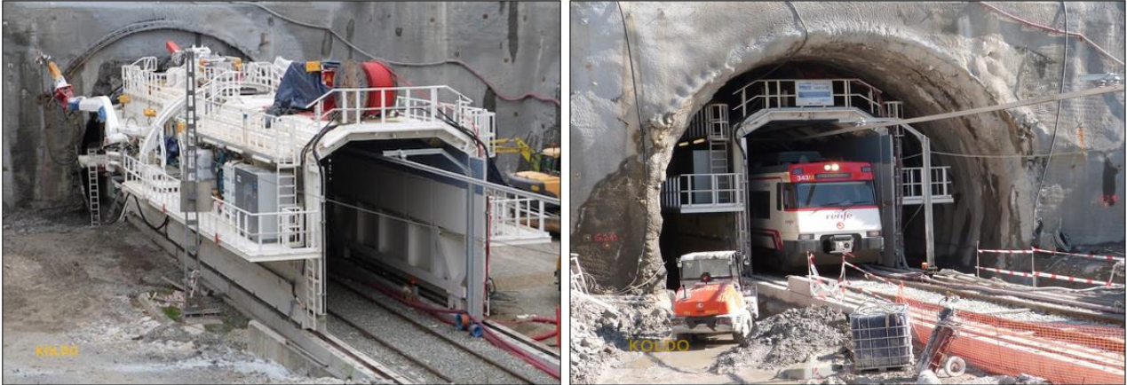
Fig 7. Máquina TES para la ampliación de túneles en servicio. (Fuente: Periódico construcción, 2018)
