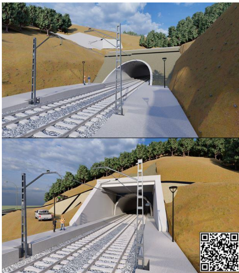
Fig 8. Imágenes de emboquilles y vídeo (QR) del túnel ampliado.
